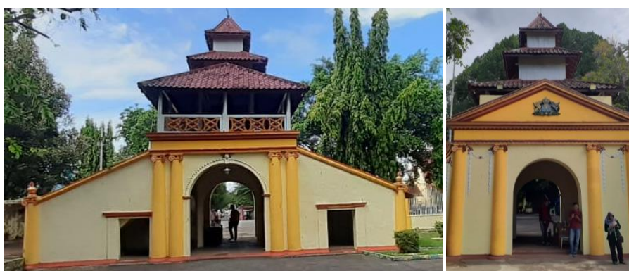
Gambar 1. Pintu Gerbang (Labang Mesem) Keraton Sumenep Tampak Dalam (Kiri) dan Tampak Depan (Kanan)
